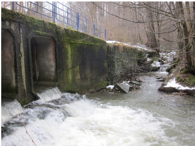
Spára mezi prefabrikáty (OP2)
