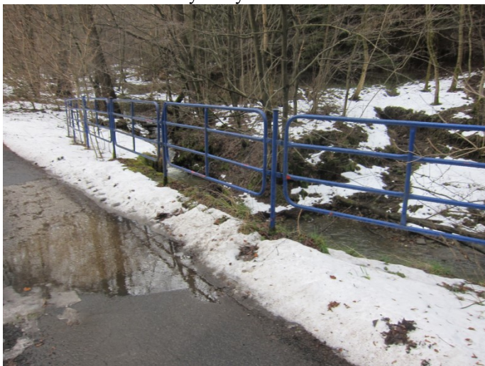
Zábradlí a zanesené římsy na výtoku
